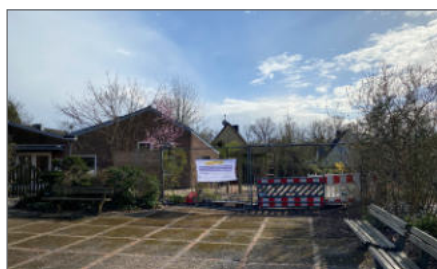
Bauzaun vor dem künftigen Kita-Gelände
